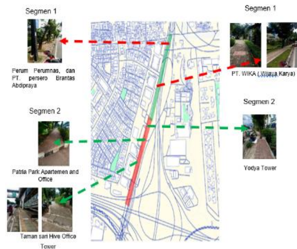
Gambar 6 Kondisi Jalur Pedestrian di Jalan DI. Panjaitan
