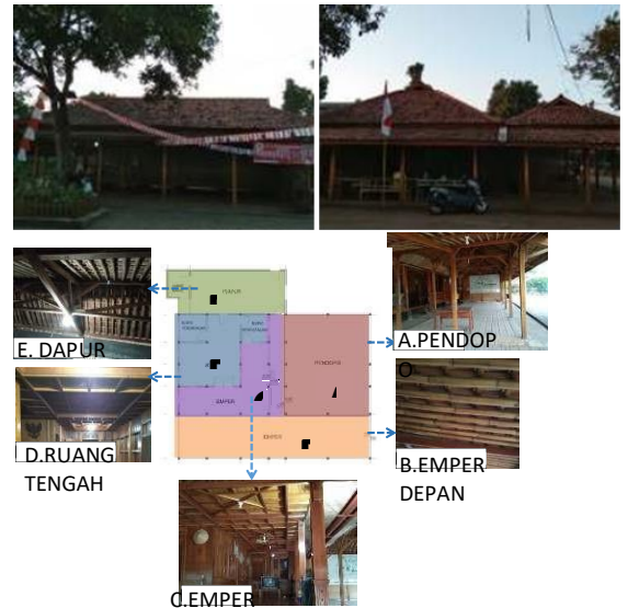
Gambar 15 Material Atap Rumah Sunda Jati Sampurna Bekasi
